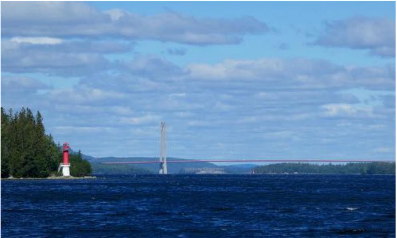
Schweden: Die maximale Stützweite der Brücke beträgt 1.210 m und ist damit fast ebenso lang wie die der Golden Gate Bridge (1.280 m). Ihre lichte Höhe beläuft sich auf 40 m, die Gesamthöhe auf 186 m bei einer Gesamtlänge von 1.867 m. Die Brücke ist 17,8 m breit.
